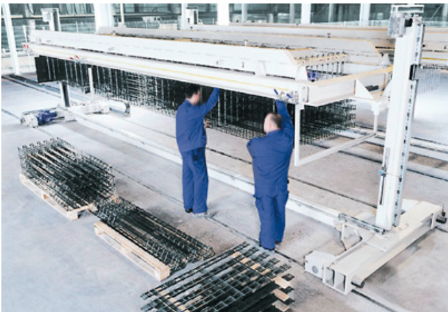
Сборка арматурных каркасов
